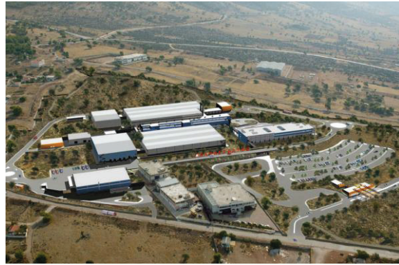
Εικόνα 24:Εγκαταστάσεις της " Παπαστράτος " στον Ασπρόπυργο
