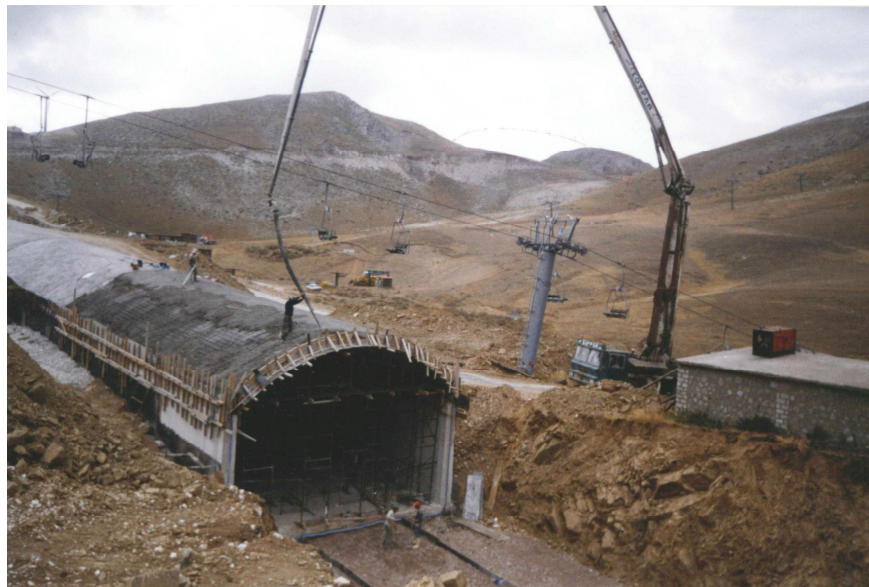
Εικόνα 1: Κατασκευή δύο θυροφραγμάτων επί του ποταμού Καλέντζη.
