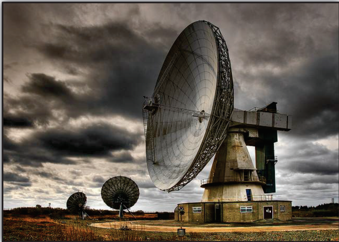
Σταθμός στο Goonhilly
