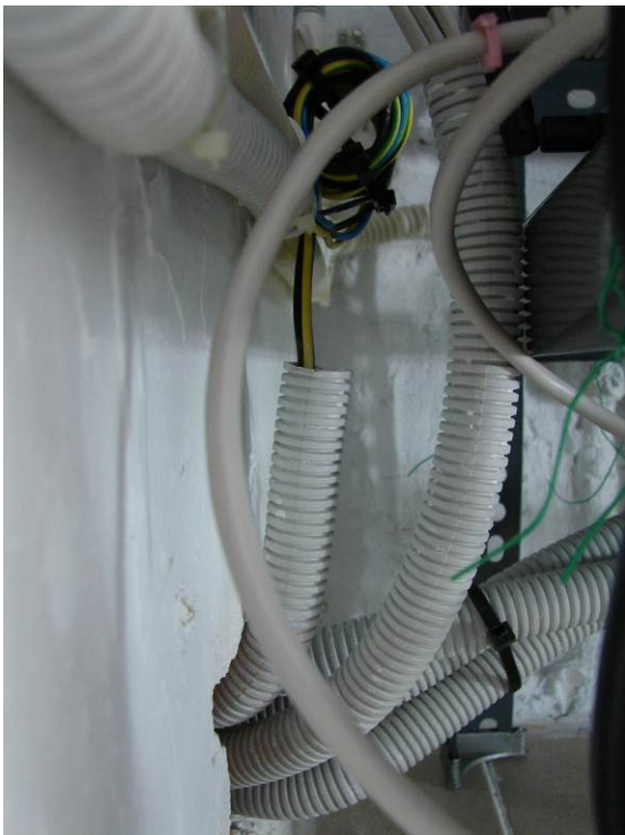
Εικ. 54-55-56-57 Συγκέντρωση καλωδίων δεδομένων, συναγερμού και ισχυρών ρευμάτων τροφοδοσίας Rack
