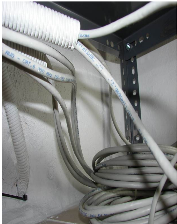
Εικ. 54-55-56-57 Συγκέντρωση καλωδίων δεδομένων, συναγερμού και ισχυρών ρευμάτων τροφοδοσίας Rack
