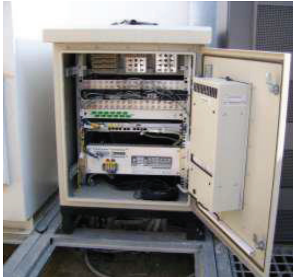
Εικόνα 22: Εγκατάσταση οπτικού κατανομητή (γ)
