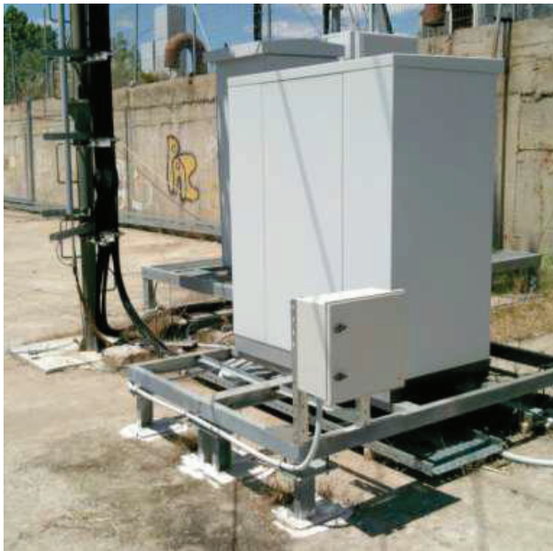
Εικόνα 23: Εγκατάσταση οπτικού κατανομητή (δ)
