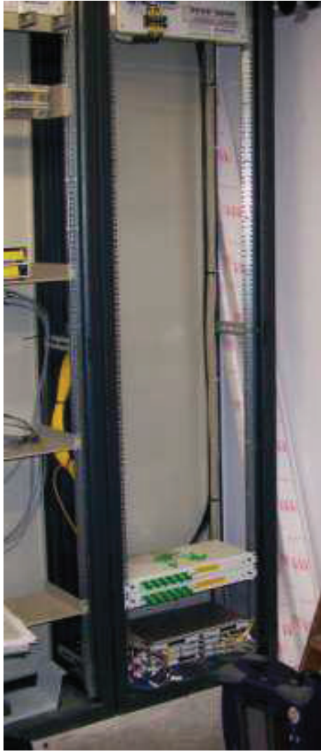
Εικόνα 20: Εγκατάσταση οπτικού κατανεμητή (α)
