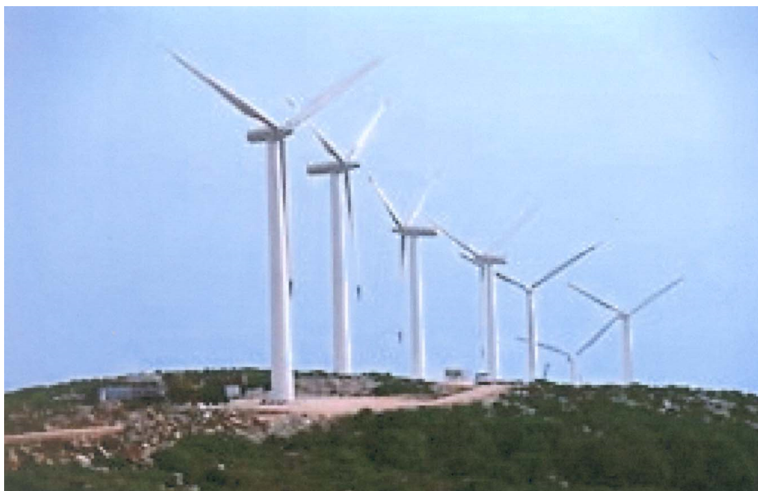
Ανεμογεννήτριες στο νησί Αντικυθήρων
