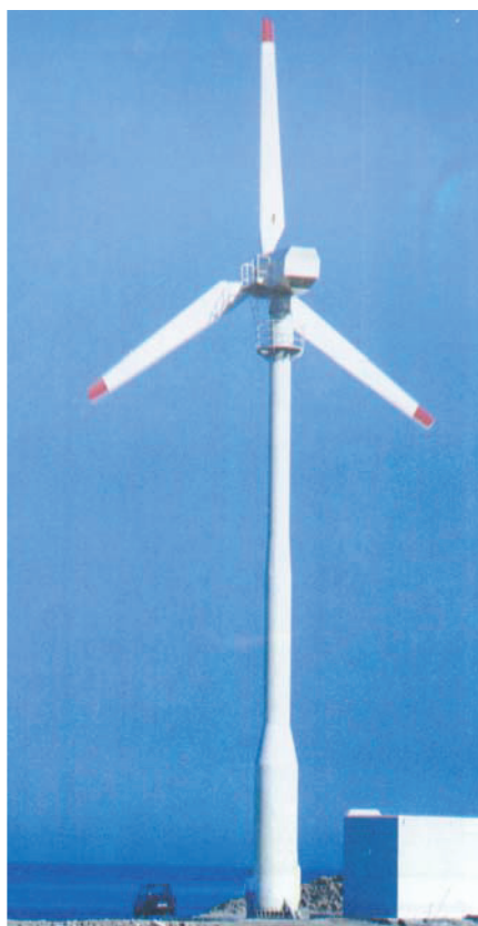
Φωτογραφία 1.11. Ανεμοκινητήρας ονομαστικής ισχύος 150KW, ελληνικής σχεδίασης και κατασκευής.
