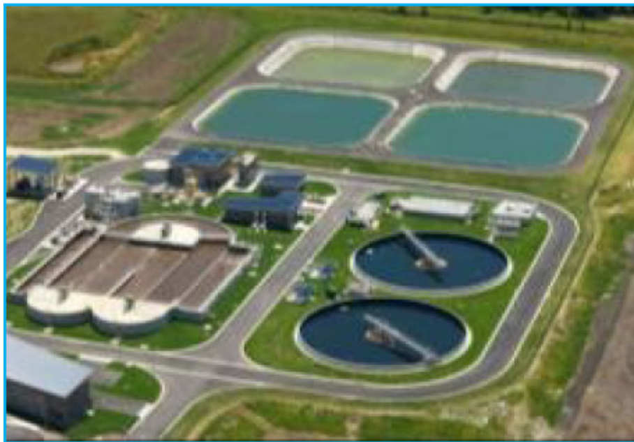
Εικόνα 3-8 : Δεξαμενές ή λίμνες σταθεροποίησης λυμάτων
