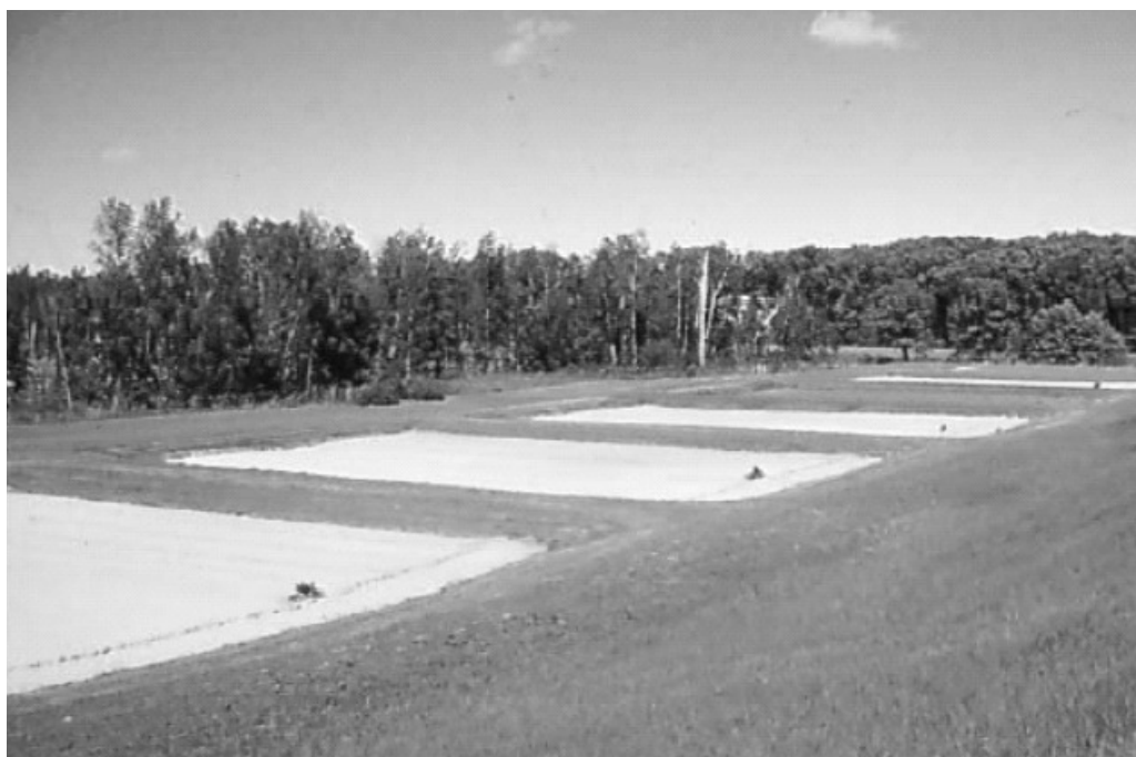
Εικόνα 5-1: Λεκάνες ταχείας διήθησης
