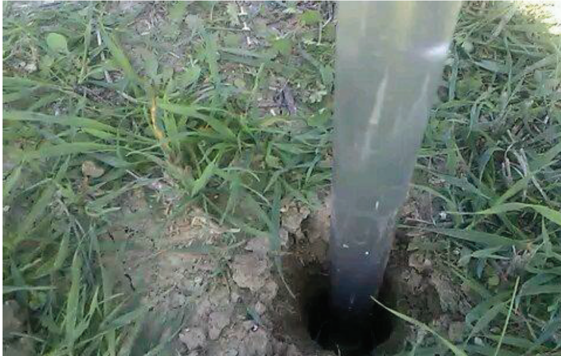
Εικόνα 5.5 Τοποθέτηση περατόμετρου στο σημείο 1
