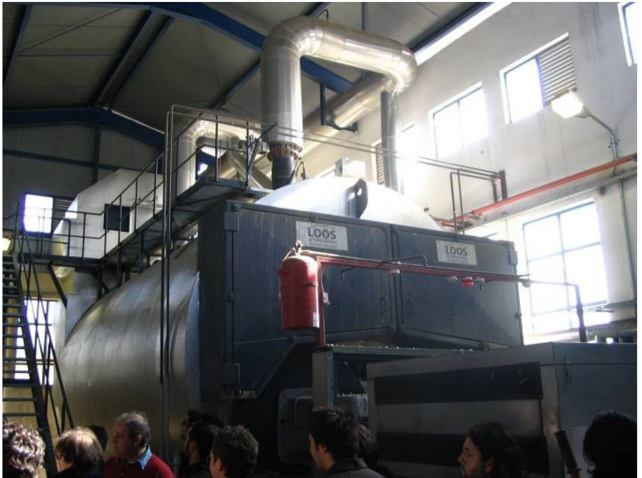
Σύστημα μεταφοράς θερμότητας και δίκτυο διανομής
